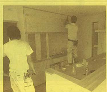
システムキッチンを設置しています。
